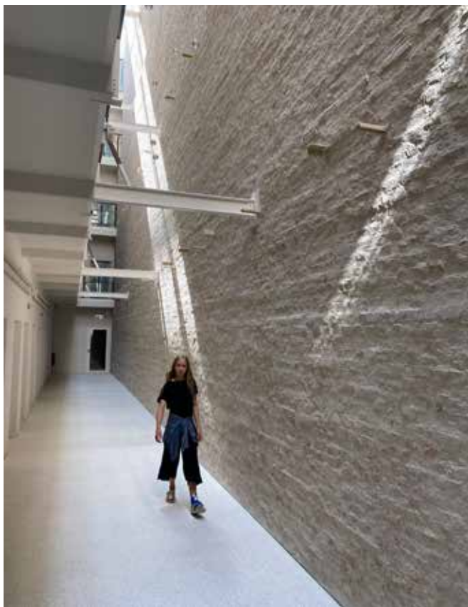
Bild 8 Ein Oberlichtband flutet zenitales Tageslicht entlang der hell geschlammten Ziegelsteinwand
