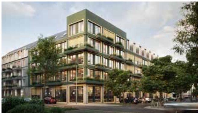
Bild 3 Südwestliche Ansicht des Büro- und Wohngebäudes VINZENT
