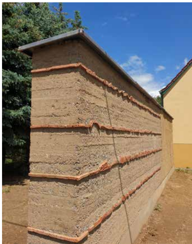
Bild 9 Demonstrationswand: im Vordergrund der Stampflehmabschnitt mit Schichten von gelochten Bienensteinen aus gebranntem Ton, die gleichzeitig auch als Erosionsbremsen gegen herablaufendes Regenwasser dienen; der hintere Teil der Wand ist aus Wellerlehmblöcken gefertigt
