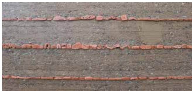
Bild 14 Bienensteine aus schwach gebranntem Ton in Stampflehm (Testwand in Nebelin); die primäre, erprobte Funktion dieser Bienensteine ist, bei Regen als Erosionsbremsen die Fließgeschwindigkeit von an der Wand herablaufendem Wasser zu reduzieren
