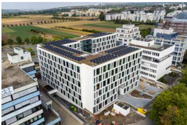
Bild 3 Die Photovoltaikanlage bedeckt die gesamte Dachfläche des Innovation Centers
