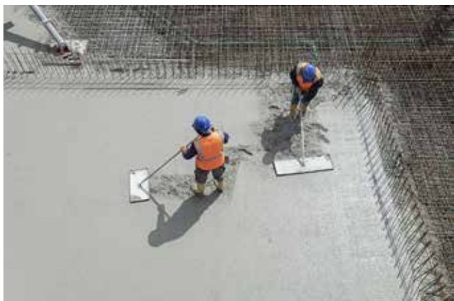
Bild 2 CO 2 -reduzierter Beton in der Verarbeitung
