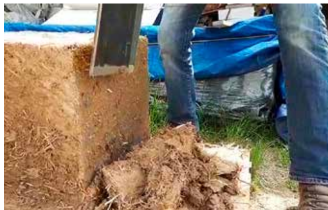
Bild 6 Das sog. „Abstechen“ einer Wellerlehmwand in der traditionellen Wellerlehm Bauweise
