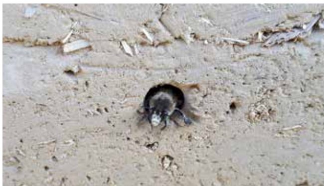
Bild 21 Eine Solitärbiene in einer Wellerlehmwand – zu erkennen sind die abgeschnittenen Halme, die beim Wellerlehmbau die Funktionen einer Armierung und von Erosionsbremsen erfüllen
