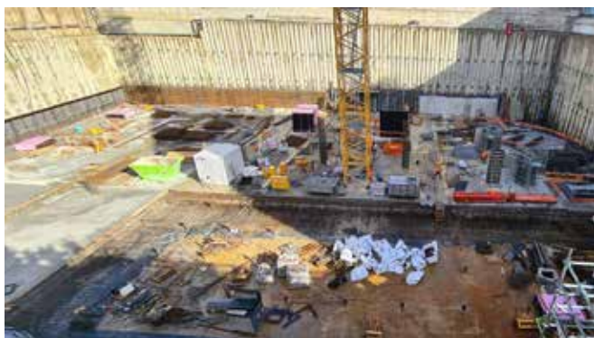
Bild 4 Ausführung der Fundamentplatte
