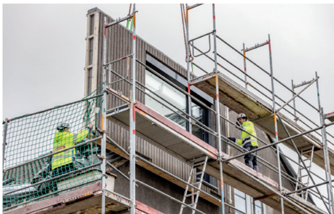
Bild 4 Montage der Elemente an bestehende Außenwand
