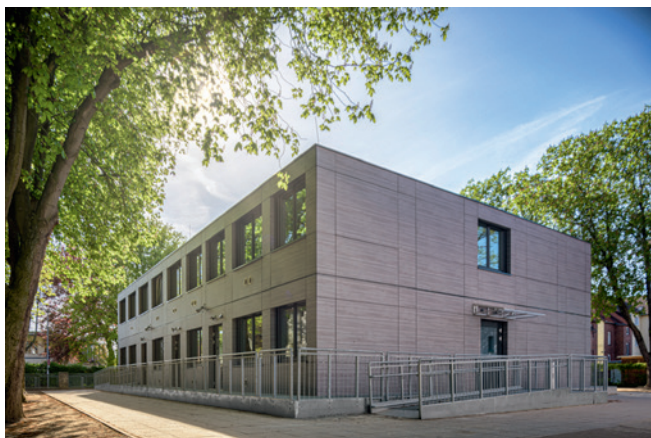
Bild 2 Für die Grundschule in Sarstedt plante Adapteo zwölf Monoblocks als Einzel-Wärmepumpen
