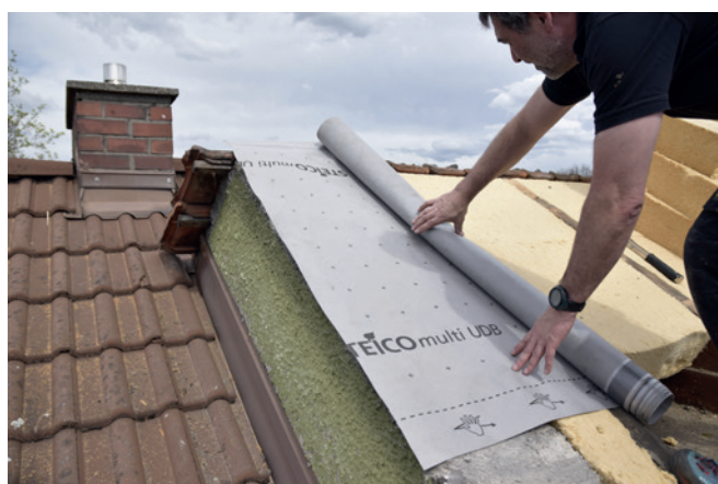
Bild 6 Über der Sparrenebene wird eine hochdiffusionsoffene Luftdichtungsbahn verlegt
