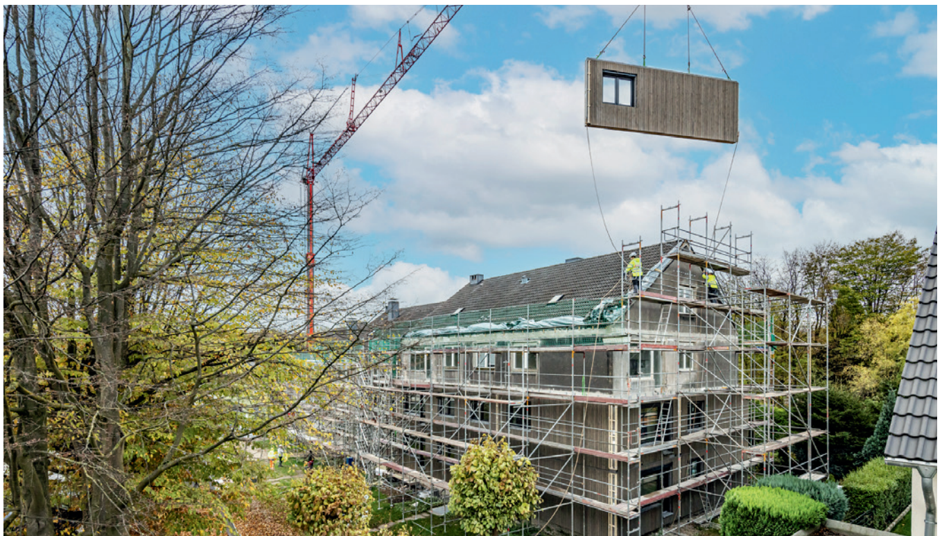
Bild 3 Hieven der Elemente vom Tieflader zum Einbauort hinter dem Gerüst
