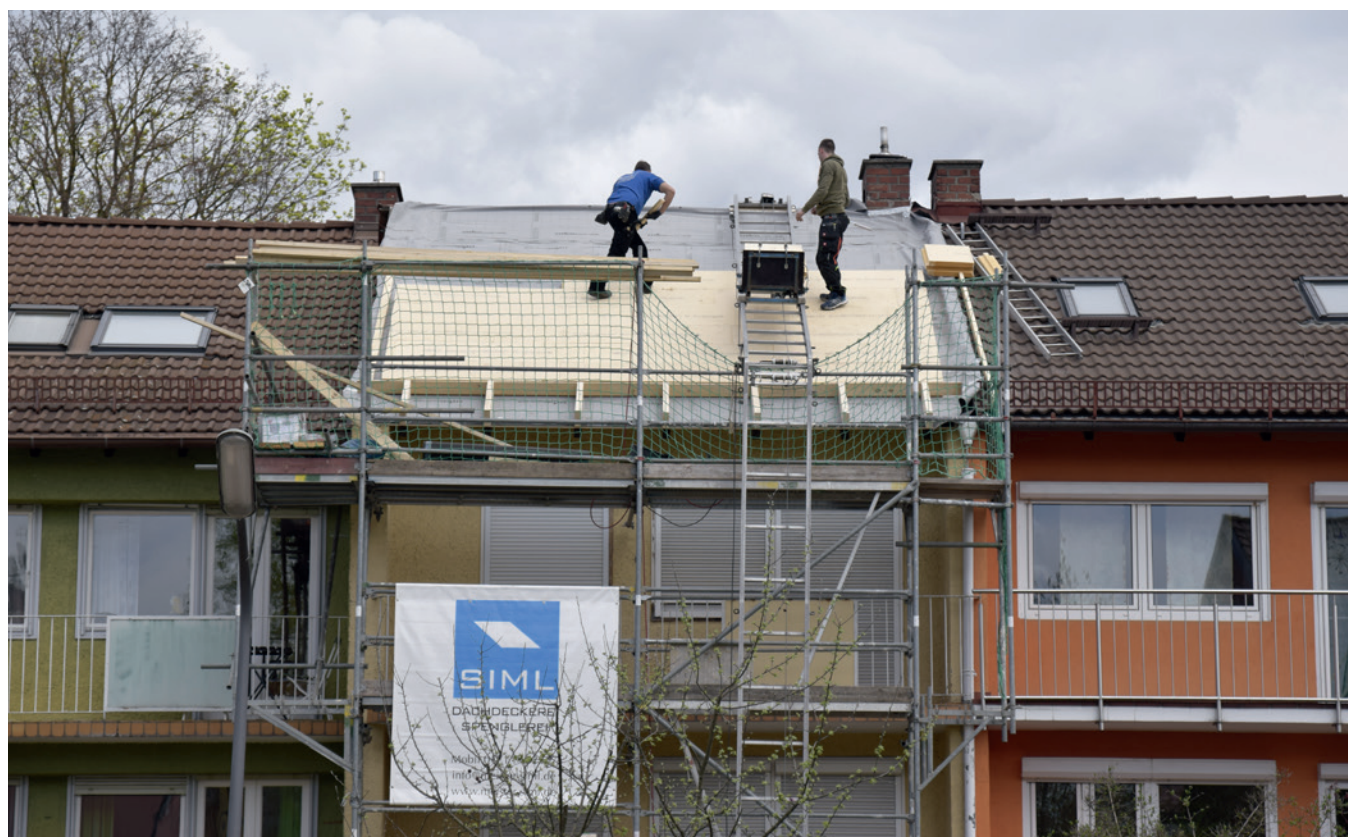
Bild 1 Energetische Dachsanierung bei einem 1960er-Jahre-Reihenhaus in München
