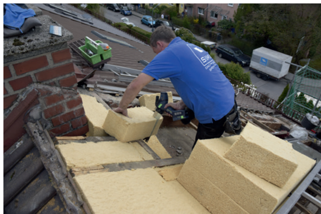
Bild 5 Die Gefache werden sparrenhoch mit einer flexiblen Holzfaser-Dämmmatte gefüllt
