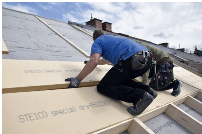
Bild 7 Auf die Luftdichtungsbahn kommt eine 16 cm dicke Holzfaser-Unterdeckplatte
