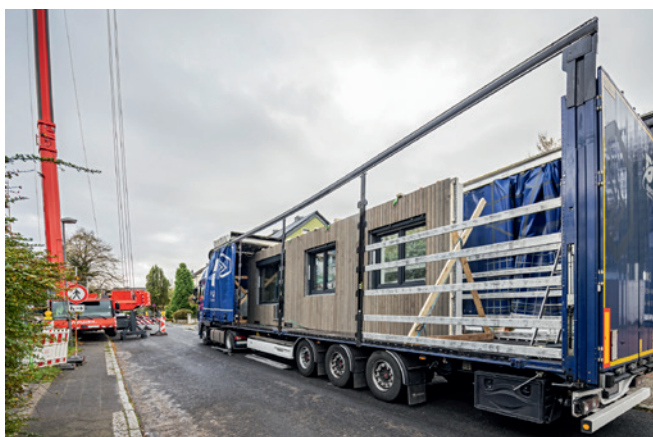
Bild 2 Anlieferung der Elemente mit eingebauten Fenstern
