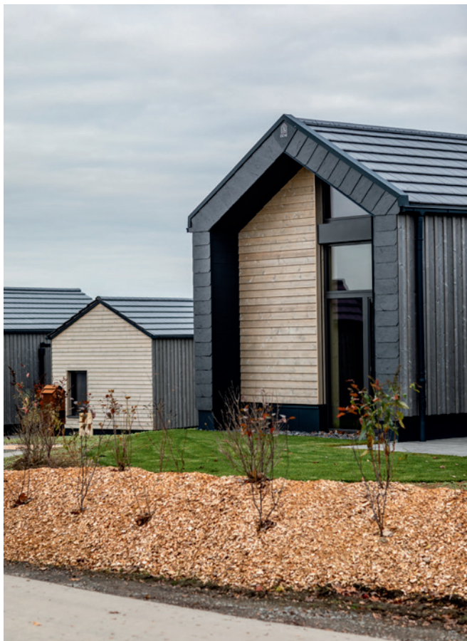
Bild 1 Die Massivholzhäuser des Projekts MANOAH – Häuser am See sind mit hochwertigen Naturmaterialien nachhaltig ausgestattet – u. a. mit Fußböden von Altro
