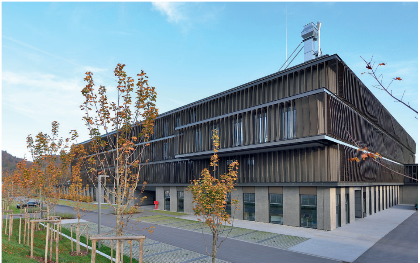
Bild 1 Berufliches Schulzentrum mit „Donauwellen“: die beweglichen Lamellen der vorgehängten Sonnenschutzfassade folgen dem Sonnenstand und zeichnen dabei ein Wellenmuster
