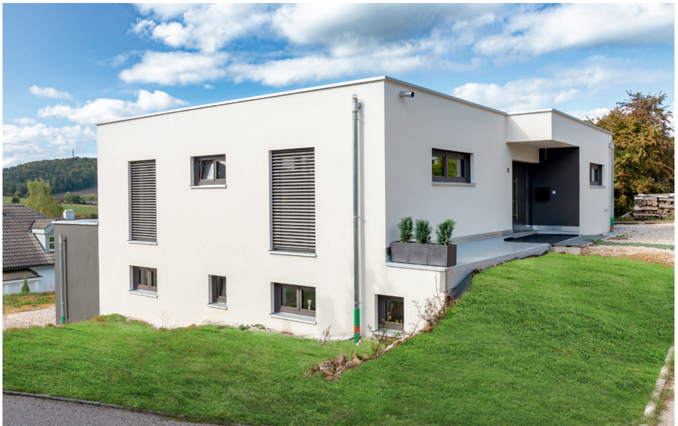
Bild 1 Die gesamte Gebäudehülle wurde mit dem MEIER M10 Wärmedämmblock aus Liapor-Leichtbeton errichtet
