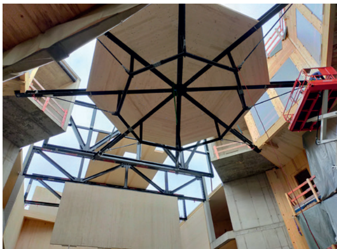
Bild 6 Getragen wird die unterspannte Terrassendecke u. a. von dem Fachwerkträger zwischen den Flucht-Treppenhäusern
