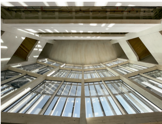
Bild 4 Blick in den Luftraum im Eingangsbereich mit den beidseitig angeordneten Treppenhäusern in Holzbauweise
