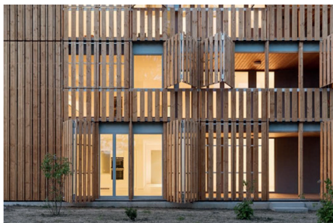
Bild 2 Mehrfamilienhaus Im Amt, Gutenswil – Verwendung nachwachsender Rohstoffe auch in der Fassade
