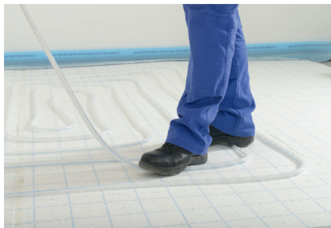
Bild 5 Uponor Klett ermöglicht eine zügige Einzelpersonenverlegung, indem die spiralförmig mit einem Klettband umwickelten Rohrleitungen einfach auf die zugehörige Verlegeplatte aufgedrückt werden
