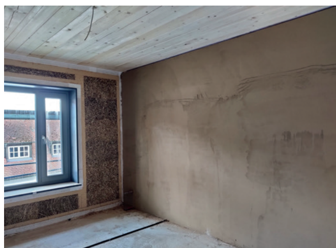
Bild 7 Vorgefertigte Wandelemente bestehend aus dem Holzrahmen und dazwischen eingelegten Strohballen sowie feuchteregulierende Lehmbauplatten final gestrichen mit einer naturfarbenen Lehmfarbe
