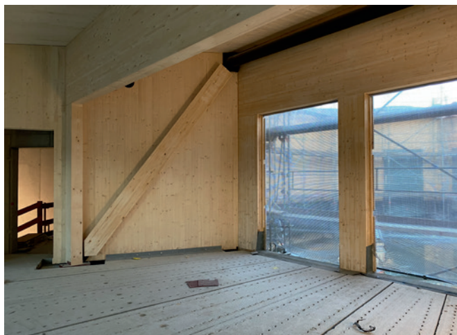
Bild 8 Anschluss der Druckstreben an den Stahlring oben und den Zugring unten; zwischen den Brettsperrholz-Druckstreben ist jeweils eine Brettsperrholzwand als Schott eingefügt
