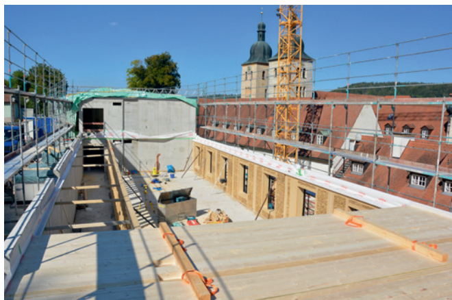
Bild 10 Einbau Mann-an-Mann-Decke
