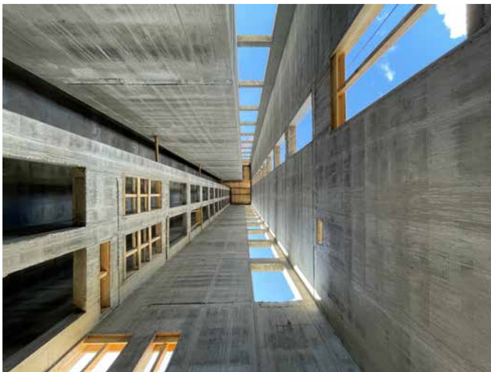
Bild 5 Innenansicht des Treppenhauskerns in Gleitbauweise
