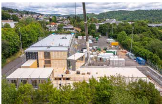
Bild 11 Prüm 2022: Die entwickelten Holzmodule werden in drei Bauabschnitten mit je einem Zeitfenster von drei Wochen montiert (hier der zweite Abschnitt)
