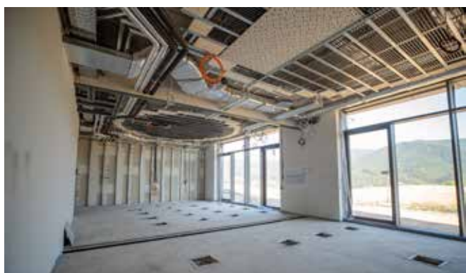
Bild 5 Rund 600 m 2 des Systems genügen, um alle erforderlichen Bereiche des Hotels zu beheizen oder zu kühlen
