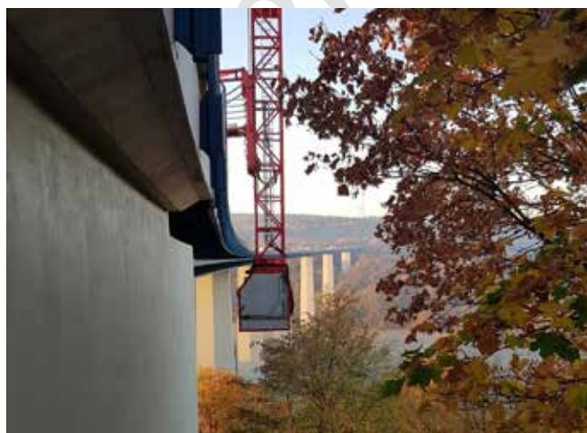
Bauwerksprüfung an der Jagsttalbrücke Widdern
