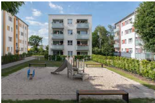
Bild 8 Nachverdichtung mit positivem Einfluss auf das Bestandsquartier
