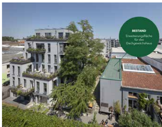
Bild 4 Bestandsgebäude ohne Gewächshaus
