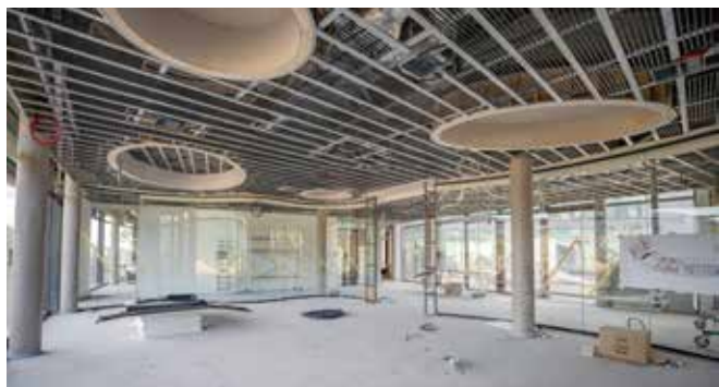
Bild 4 Die Klimatisierung erfolgt über die Decke mittels Heiz- und Kühlregistern aus dem Hause aquatherm
