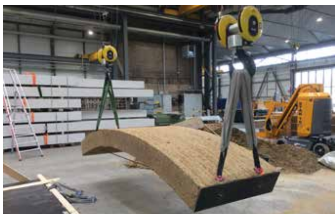
Bild 9 Bogenelement am Kran
