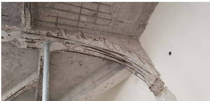
Bild 2 Freiliegender Bügelbewehrung am Kragbalken
