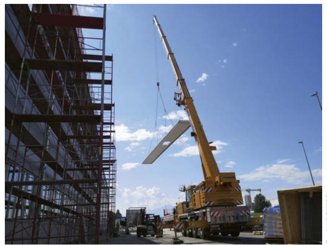
Bild 3 Sämtliche Dachelemente wurden per Mobilkran auf das Dach gehoben
