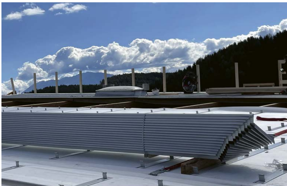
Bild 4 Das Element-Dach wurde objektbezogen bereits im Werk mit allen vorgegebenen Durchbrüchen für Lichtelemente und haustechnische Anlagen hergestellt
