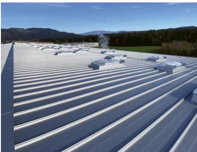
Bild 1 Der Einsatz des DOMICO Element-Dachs in Kombination mit dem Domitec-Dach ermöglichte die Sanierung von 5300 m 2 Hallendachflächen bei laufender Produktion in nur zwei Monaten
