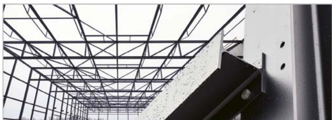
Forster Campus: Dachkonstruktion mit SWT Green Steel
