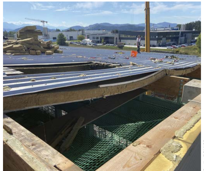
Bild 2 Durch die irreparable Delamination des Verbundsystems versagte die Eigenstatik des Systems; zudem gelangte Niederschlagswasser in die Dachkonstruktion und in das Gebäudeinnere
