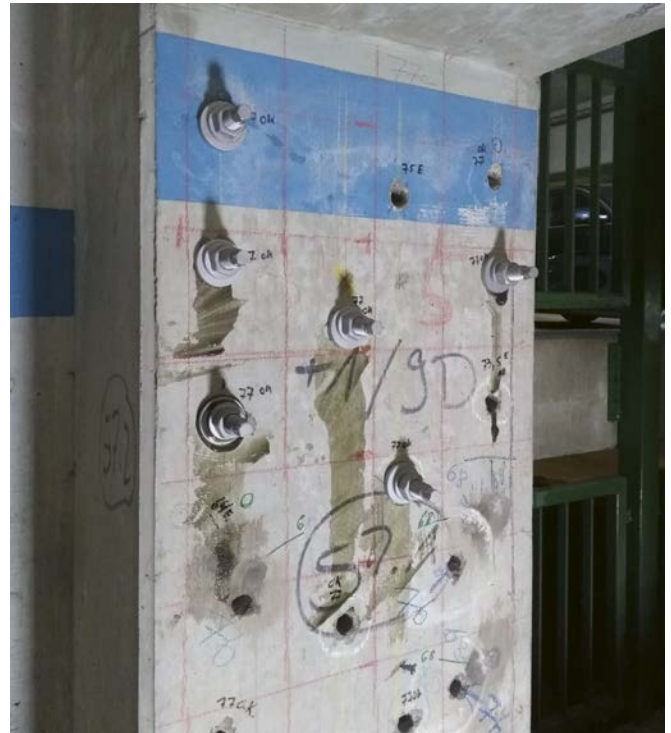
Bild 1 Erstellte Bohrlöcher in einem Rahmenstiel unter Aufrechterhaltung der Nutzung des Parkhauses
